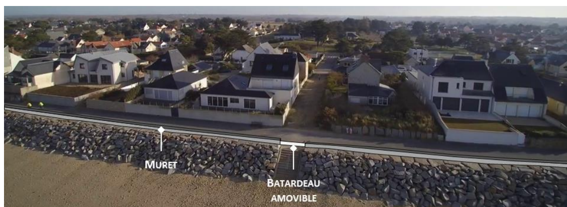
Figure 65. Exemple d'intégration schématique de la solution « muret + batardeau » au niveau de la zone 3 (Source : Youtube©).
