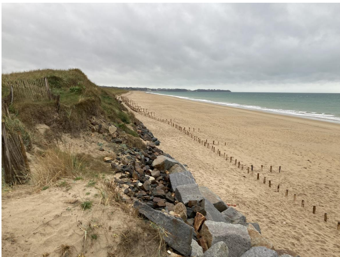
Figure 18. Photographie du cordon en enrochements au Sud de la protection en enrochements (11/2022, CASAGEC Ingénierie).
