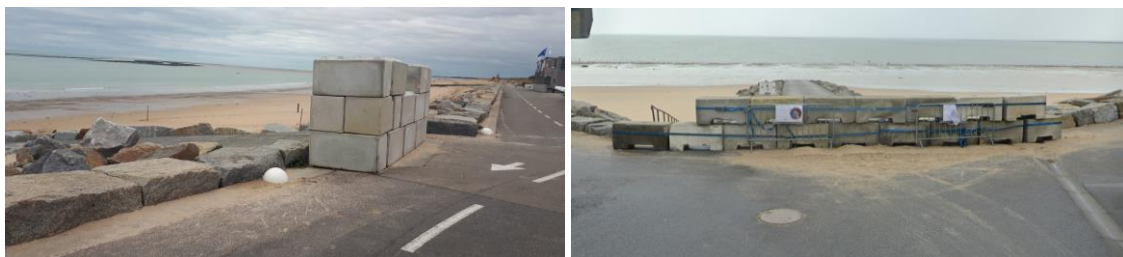
Figure 66. Blocs béton mis en place au niveau de la cale Nord (gauche) et de la cale de la Vigie (Droite) (Source : Google Street View).
